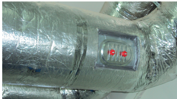
Rys. Przykład zamontowania klapy rewizyjnej IPR
