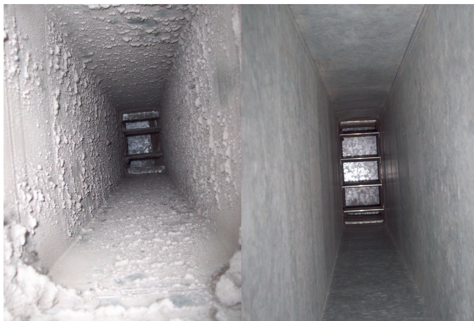
Rys. Kanały wentylacyjne przed oraz po czyszczeniu
